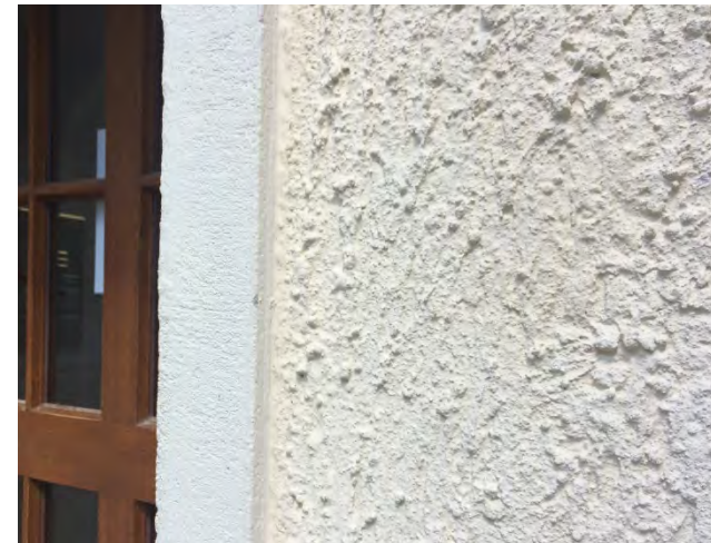
Unterschiedliche Putzstrukturen und -details nach Sanierung
