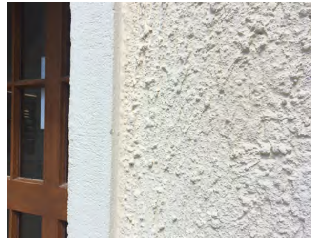
Unterschiedliche Putzstrukturen und -details nach Sanierung
